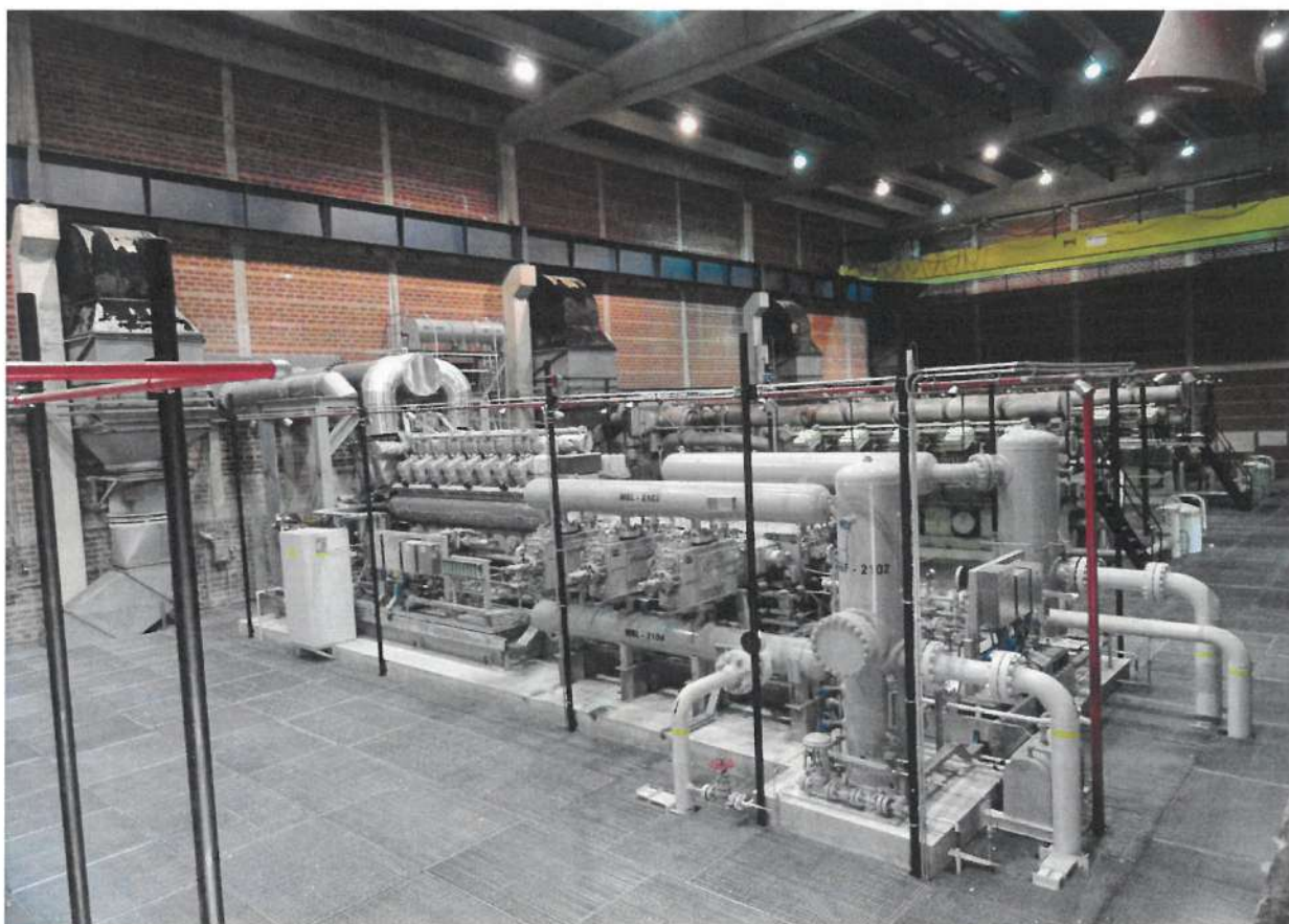
Slika 3. Nova kompresorska jedinica MK-2N
